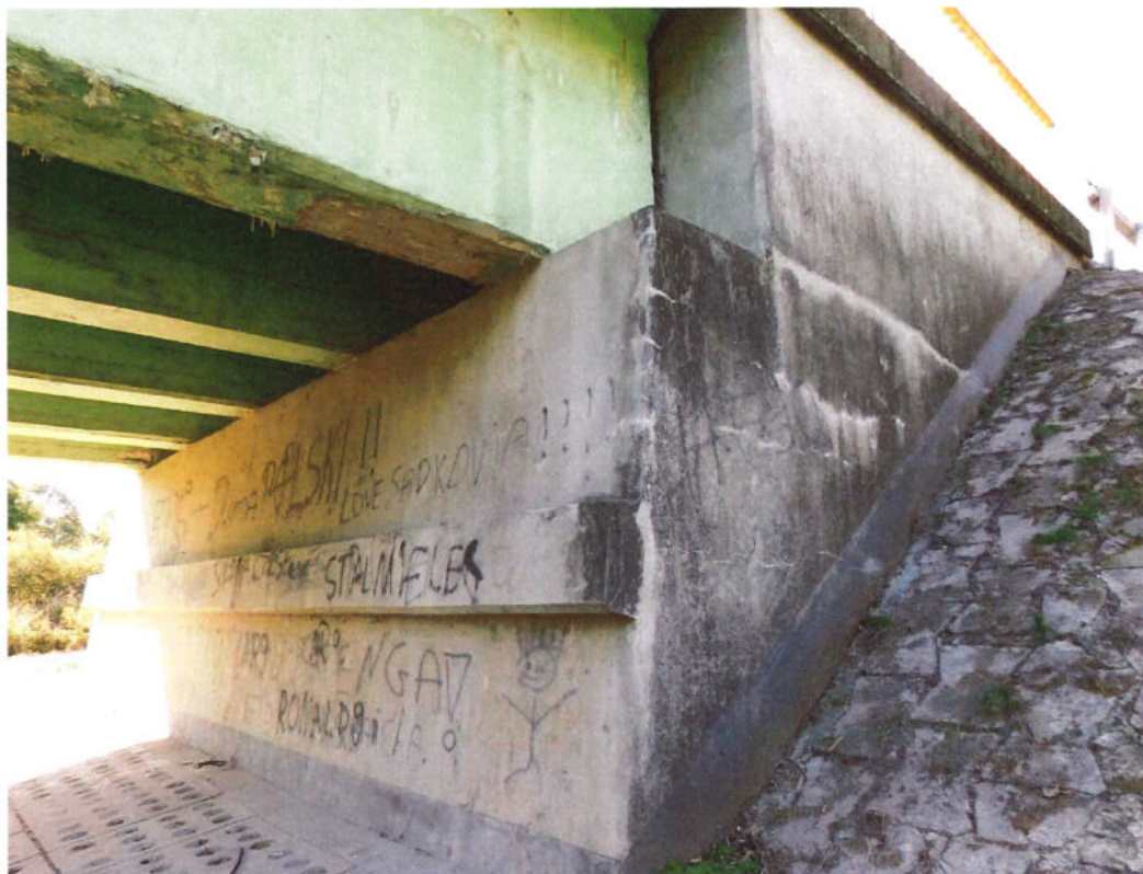
Fot. 49. Przyczółek od strony m. Szczucin – zanieczyszczenia oraz zarysowania z lokalnymi wapiennymi wylugowaniami na powierzchni ściany bocznej przyczółka.
