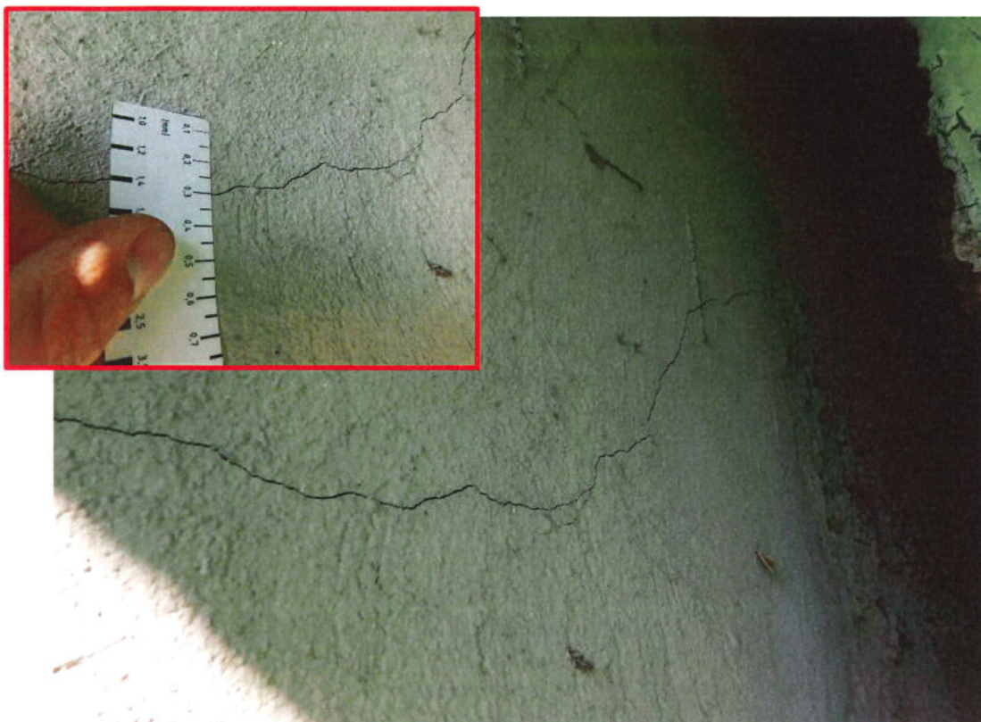
Fot. 51. Przyczółek od strony m. Szczucin – poziome zarysowanie ścianki zapleczej przyczółka, rozwartość rysy wynosi 0,3 mm.
