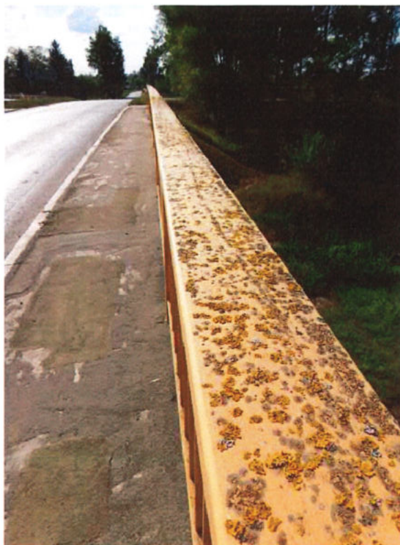
Fot. 27. Balustrada na obiekcie, GW / DW – zanieczyszczenia i osady na całej długości obu balustrad.
