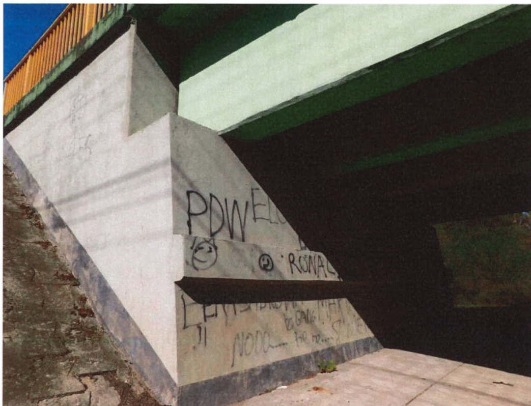
Fot. 47. Przyczółek od strony m. Szczucin – zanieczyszczenia w tym w postaci graffiti na całej powierzchni podpory.
