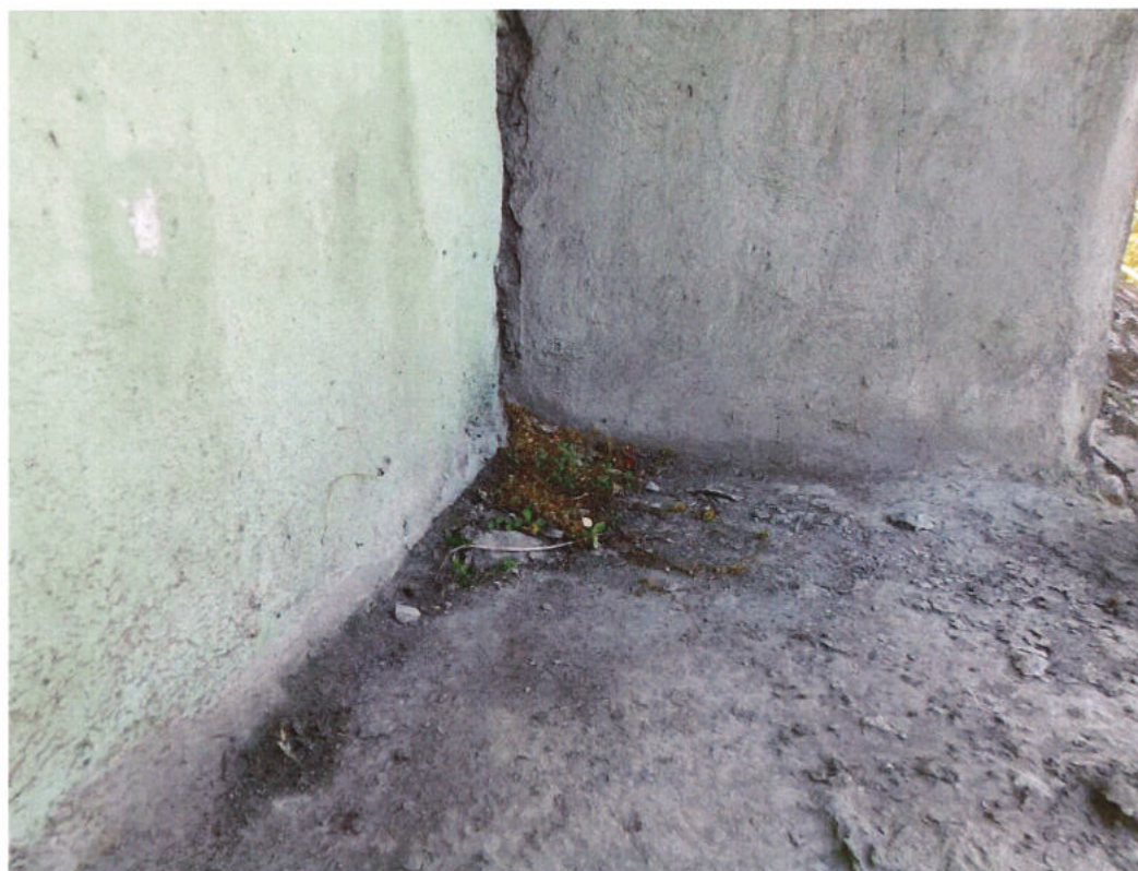
Fot. 50. Przyczółek od strony m. Szczucin – zanieczyszczenia oraz początki wegetacji roślinności na powierzchni ławy podłożyskowej przyczółka.
