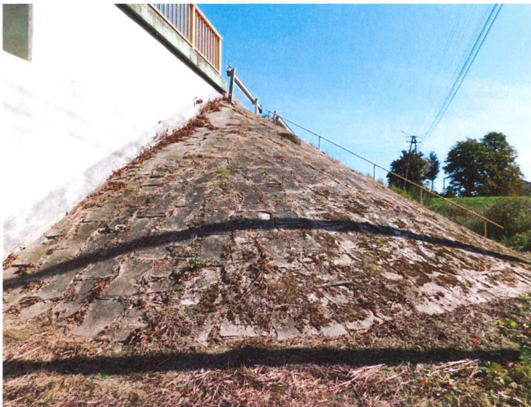
Fot. 57. Stożek nasypu od strony GW i dojazdu od strony m. Jaślany – zanieczyszczenia i wegetacja roślinności na umocnionym stożku nasypu – uszkodzenia typowe w zakresie wszystkich stożków.
