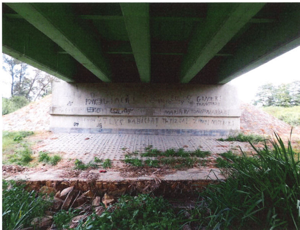
Fot. 61. Zanieczyszczenia i wegetacja roślinności na płytach ażurowych umacniających teren pod obiektem.
