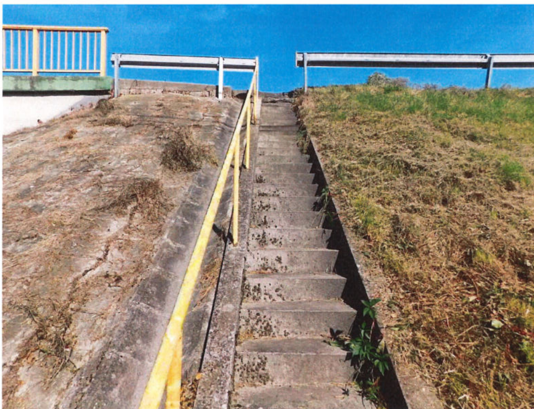
Fot. 58. Zanieczyszczenia i wegetacja roślinności na schodach skarpowych dla obsługi obiektu. Zanieczyszczenia i uszkodzenia zabezpieczeń antykorozyjnych balustrady stalowej.
