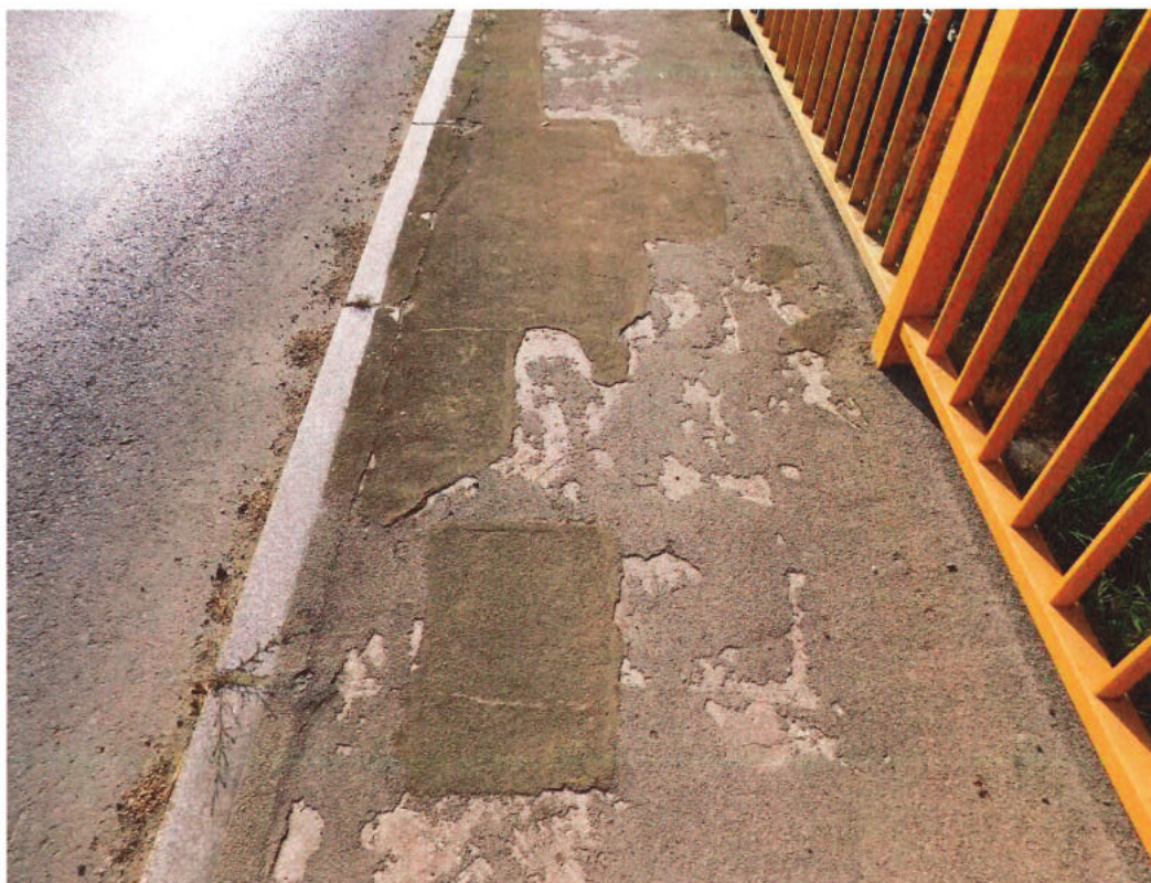
Fot. 23. Chodnik na obiekcie po stronie DW – liczne ubytki i wykruszenia żywicznej nawierzchni chodnika, widoczne ślady po naprawach nawierzchni, zanieczyszczenia w strefie przykrawężnikowej.
