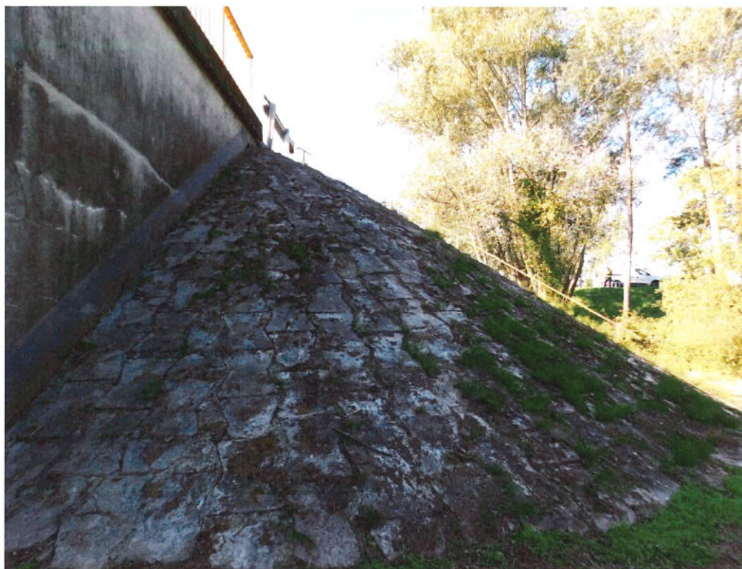
Fot. 59. Stożek nasypu od strony DW i dojazdu od strony m. Szczucin – zanieczyszczenia i wegetacja roślinności na umocnionym stożku nasypu. Strona DW – uszkodzenia typowe w zakresie wszystkich stożków.
