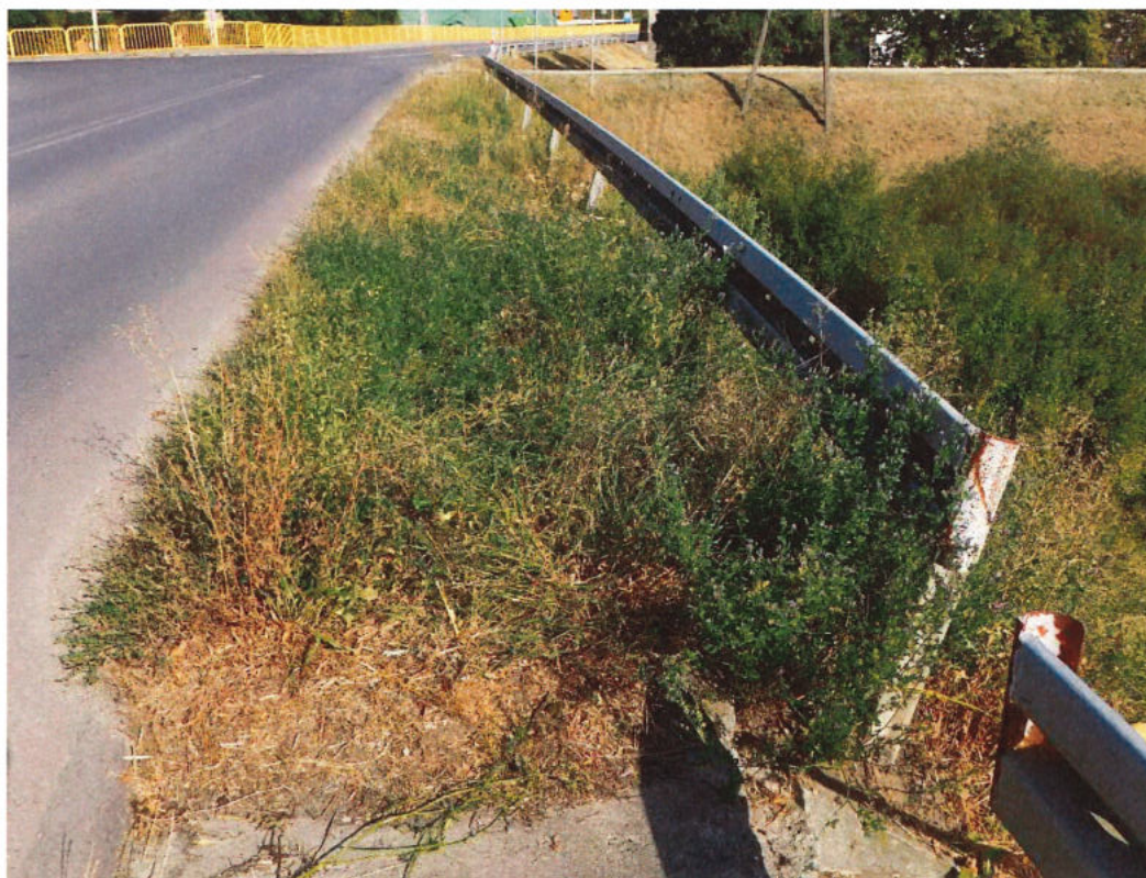
Fot. 20. Dojazd do obiektu od strony m. Jaślany – nadmiarowa wegetacja roślinności trawiastej na poboczu gruntowym.
