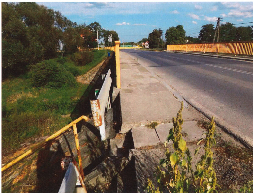
Fot. 30. Bariera ochronna na dojeździe od strony m. Szczucin – brak prostoliniowości bariery, przemieszczenia słupków, widoczne ogniska korozji na prowadnicy i słupkach bariery.
