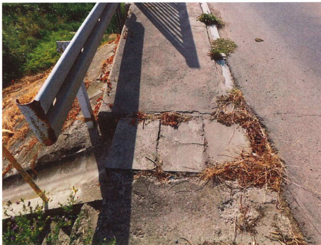
Fot. 36. Odwodnienie obiektu – zanieczyszczenia w obrębie ścieku odwodnienia mogące utrudniać swobodny spływ wody.
