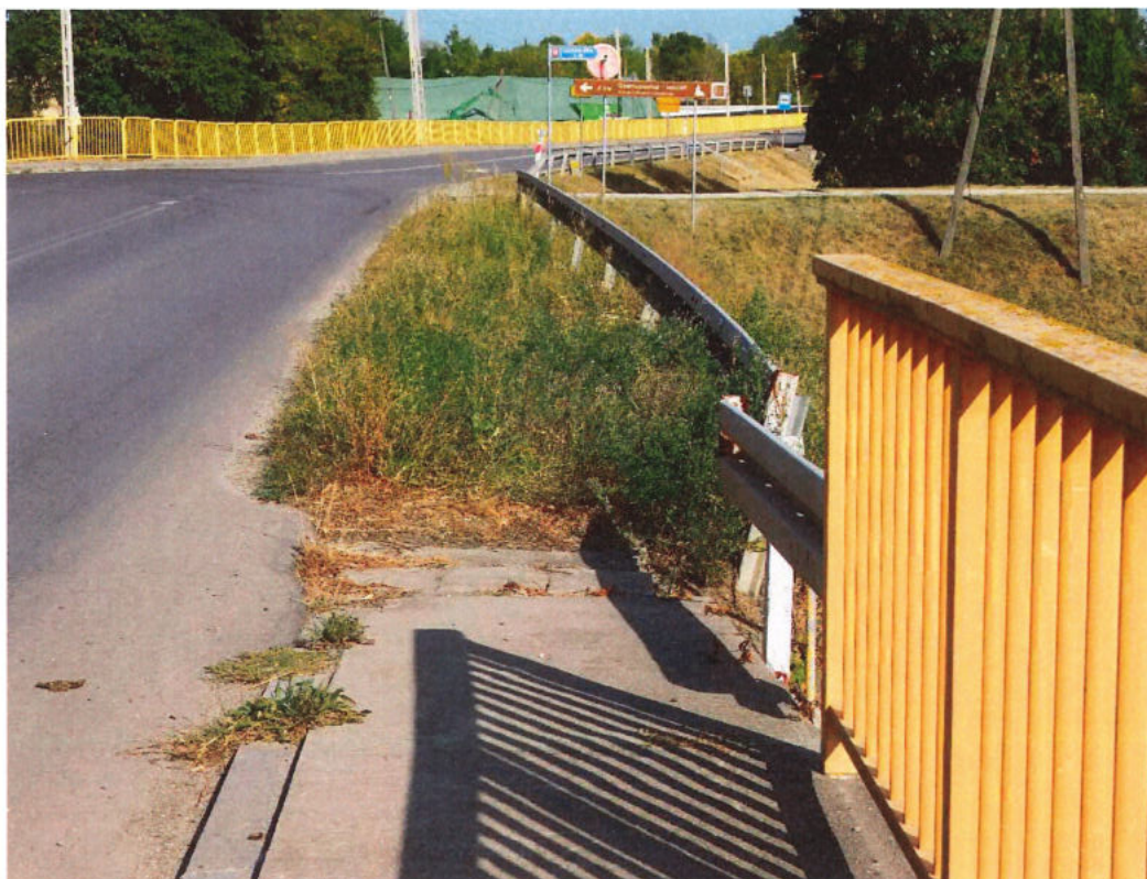
Fot. 29. Bariera ochronna na dojeździe od strony m. Jasłany – brak prostoliniowości bariery, przemieszczenia słupków, widoczne ogniska korozji na prowadnicy i słupkach.
