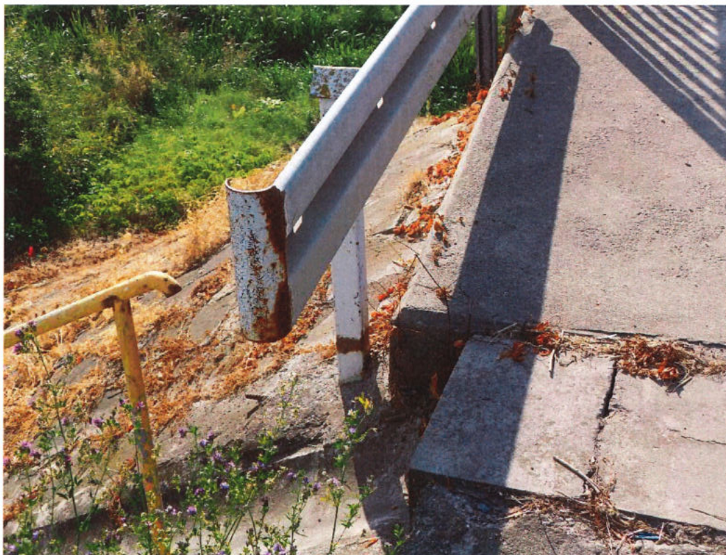
Fot. 28. Korozja powierzchniowa bariery energochłonnej na dojeździe do obiektu – dotyczy wszystkich dojazdów.
