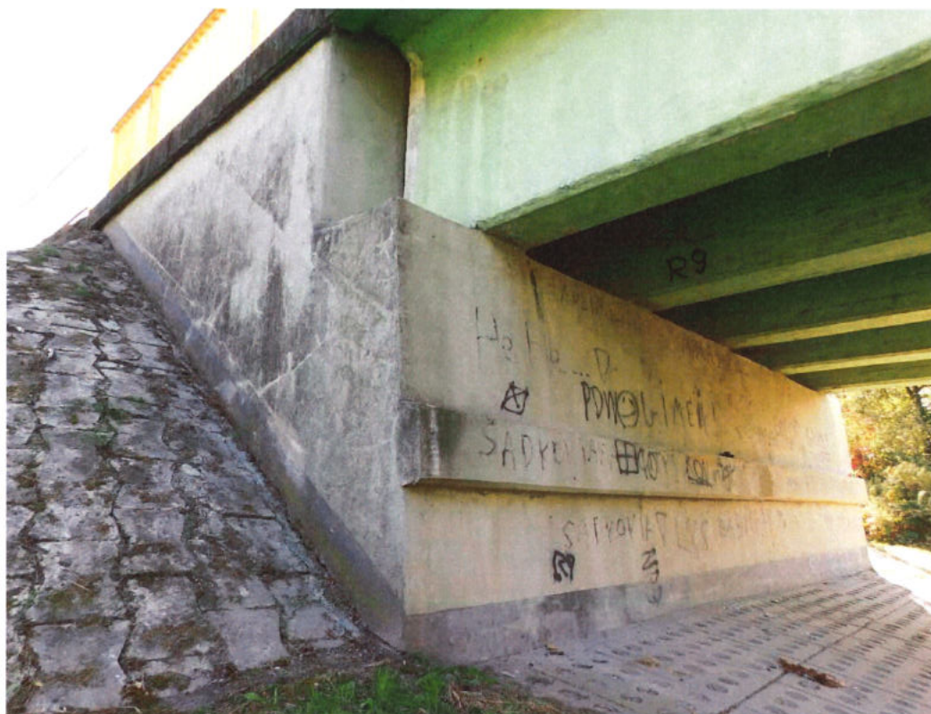
Fot. 53. Przyczółek od strony m. Jaślany – zanieczyszczenia w tym w postaci graffiti na całej powierzchni podpory.
