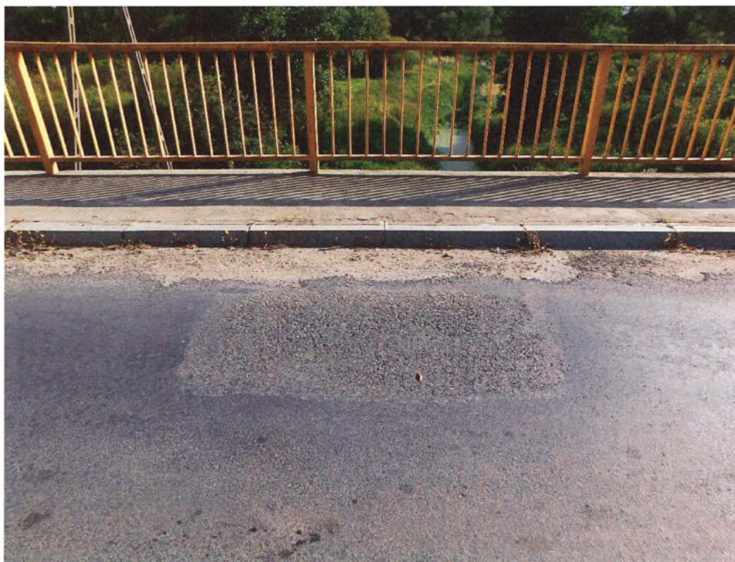
Fot. 16. Nawierzchnia jezdni na obiekcie –wykruszenia oraz lokalne deformacje bitumicznej nawierzchni, widoczne ślady po naprawach.
