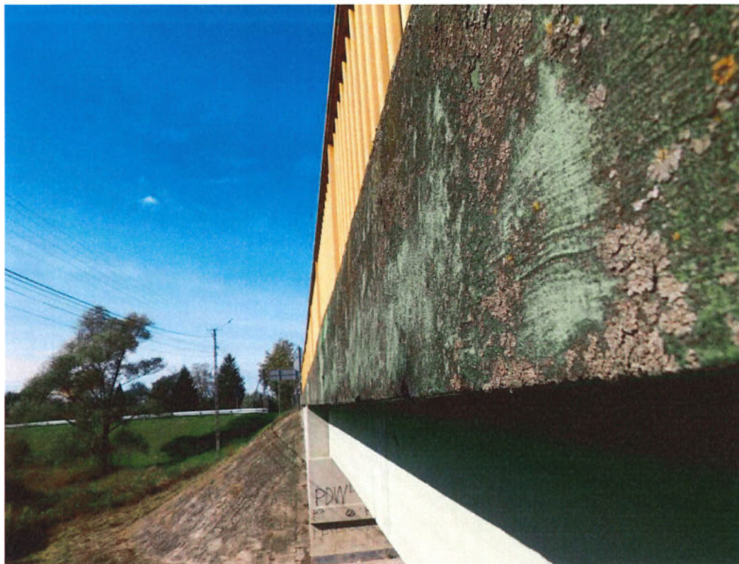
Fot. 33. Gzyms po stronie GW – zanieczyszczenia i osady na całej powierzchni gzymsu.
