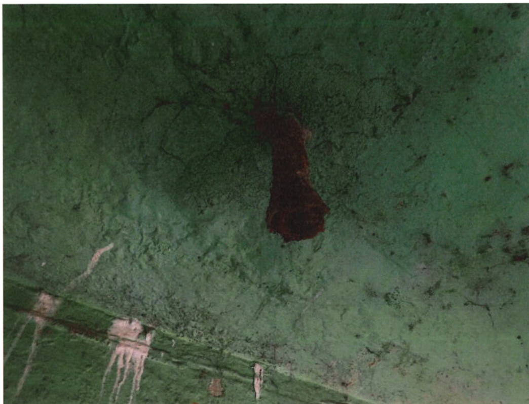
Fot. 35. Odwodnienie obiektu – zaawansowana korozja stalowej rury sączka odwodnienia – uszkodzenie dotyczy wszystkich sączków.
