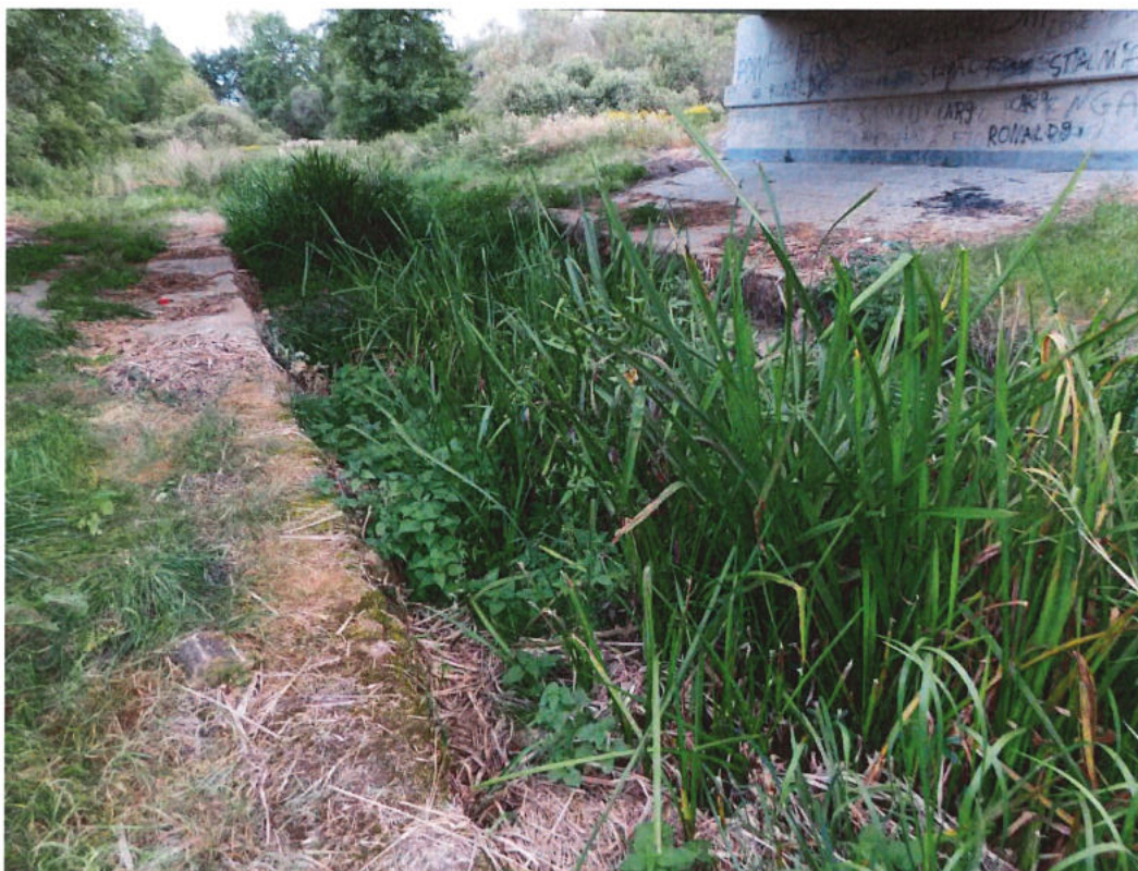
Fot. 60. Nadmiarowa wegetacja roślinności w korycie cieku pod obiektem mogąca utrudniać swobodny przepływ wody.
