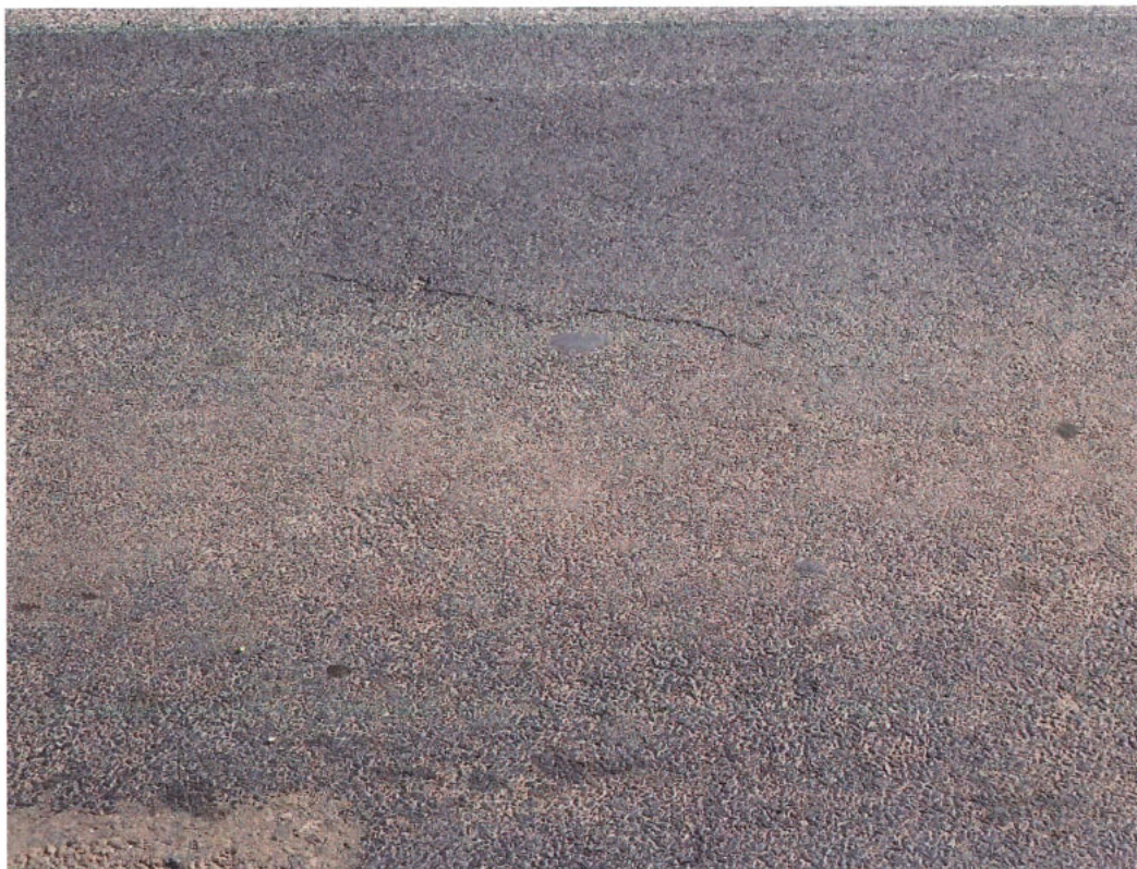
Fot. 17. Nawierzchnia jezdni na obiekcie – lokalne pęknięcie bitumicznej nawierzchni jezdni.
