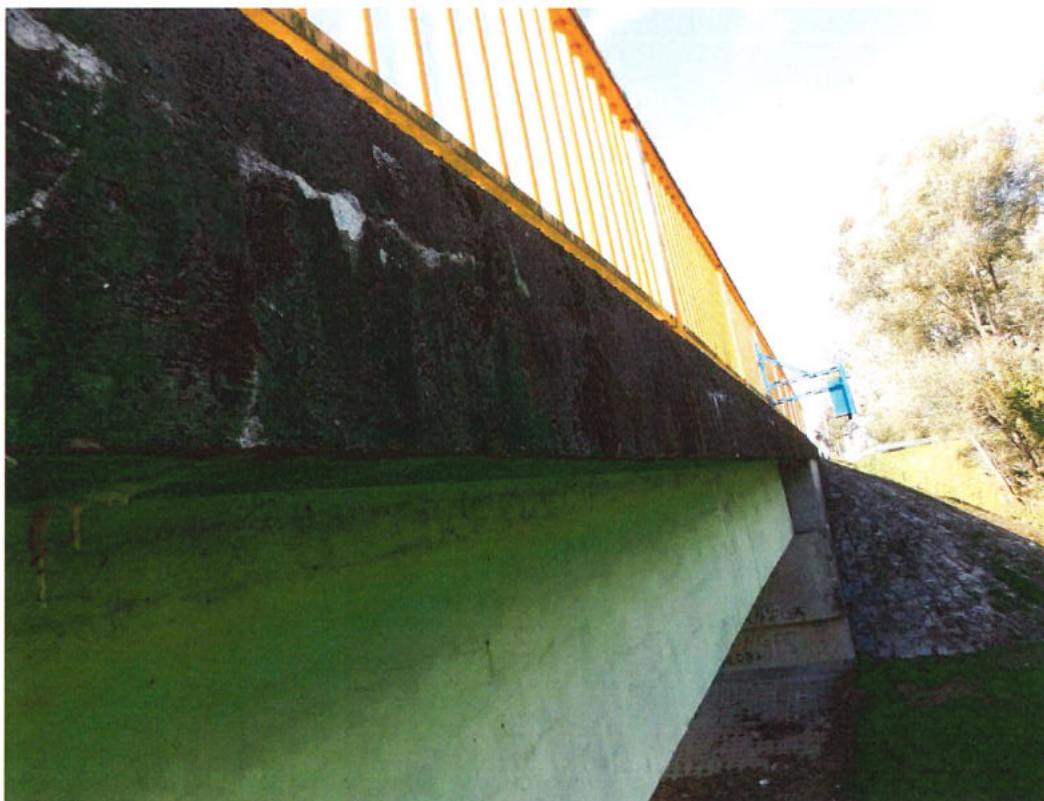
Fot. 32. Gzyms po stronie DW – lokalne zarysowania z wapiennymi wyługowaniami, osady i wegetacja mchu na całej powierzchni gzymsu.
