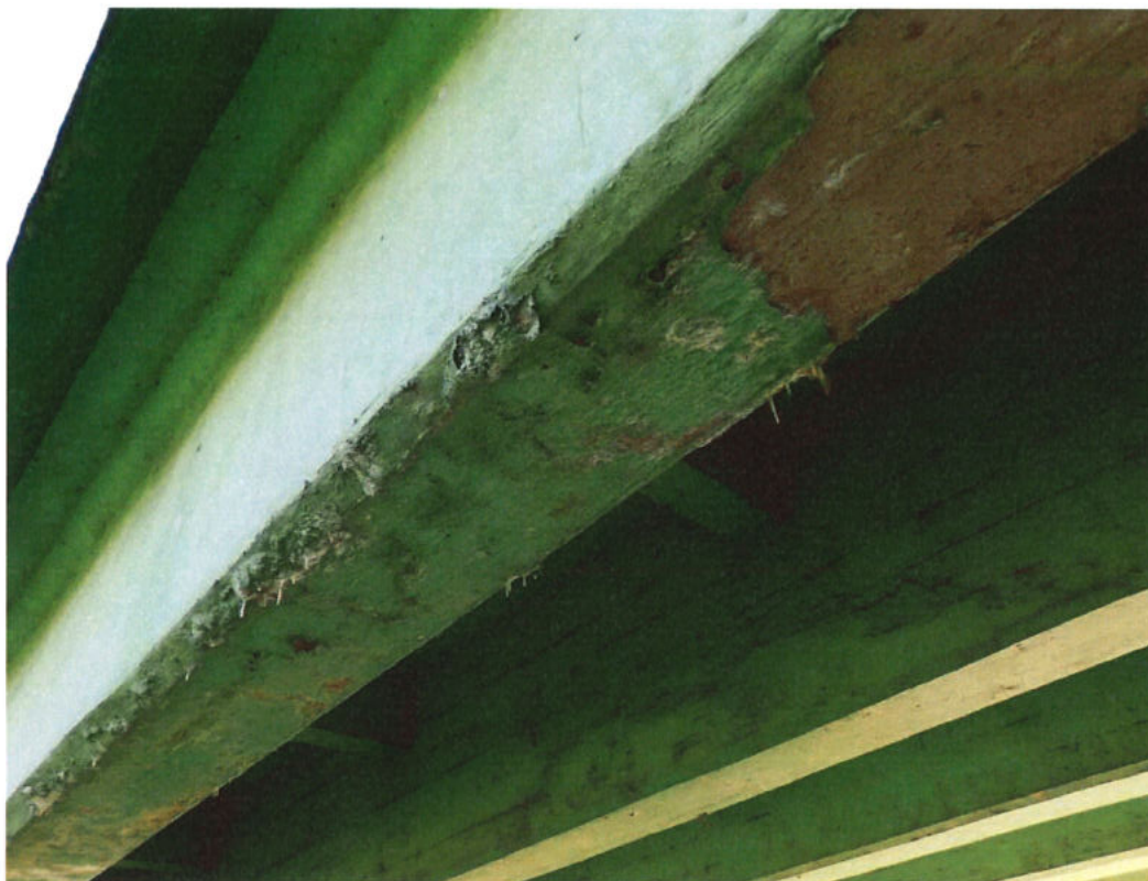
Fot. 45. Konstrukcja dźwigarów głównych – liczne zacieki i wapienne osady na powierzchni dźwigarów, uszkodzenie powłok ochronnych betonu, rdzawe zacieki świadczące o korozji zbrojenia.
