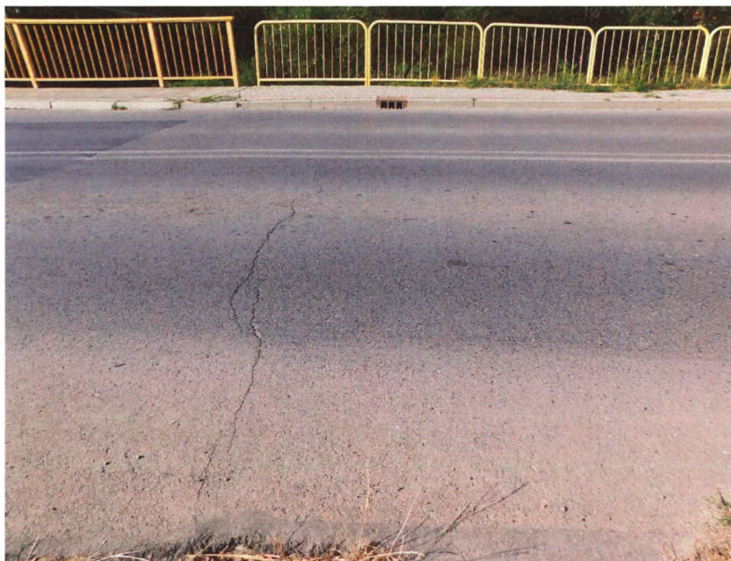
Fot. 19. Dojazd do obiektu od strony m. Jaślany – spękania i lokalne deformacje bitumicznej nawierzchni jezdni (brak płyt przejściowych).
