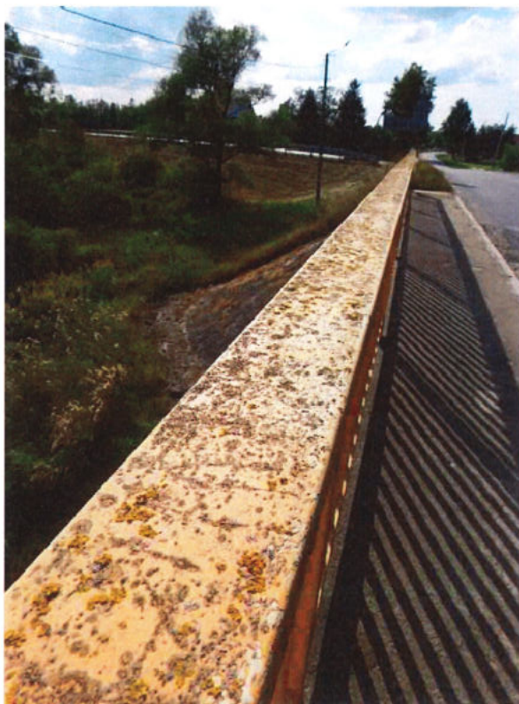
Fot. 27. Balustrada na obiekcie, GW / DW – zanieczyszczenia i osady na całej długości obu balustrad.
