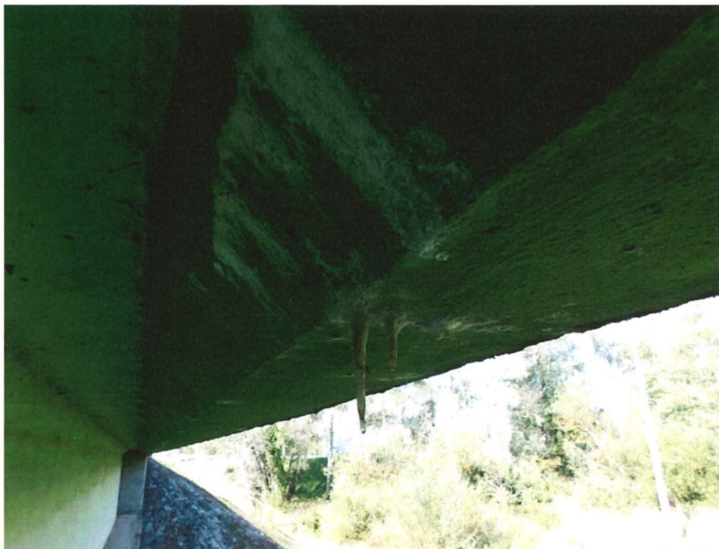
Fot. 31. Gzyms po stronie DW – lokalne wapienne osady formujące stalaktyty świadczące o korozji ługującej betonu.
