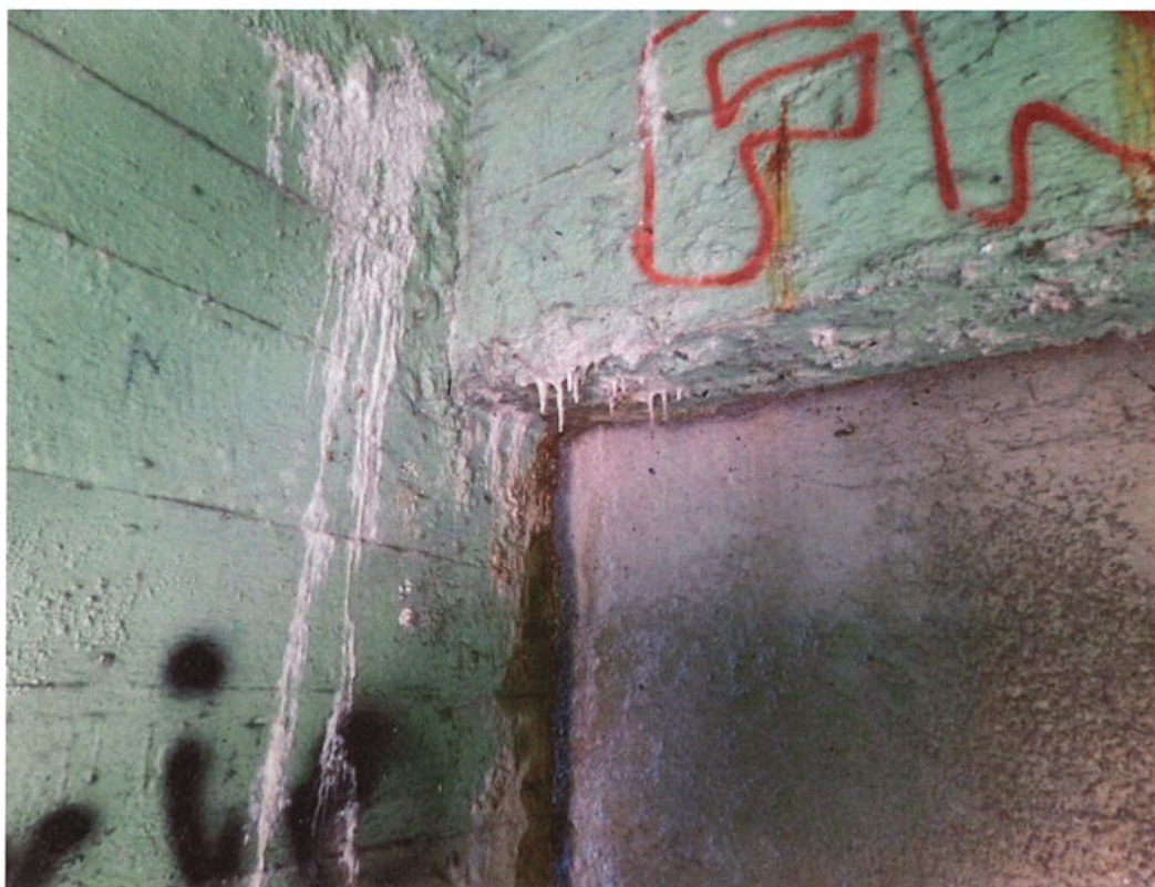
Fot. 46. Konstrukcja dźwigarów głównych – wapienne osady, lokalne rdzawe zacieki świadczące o korozji zbrojenia poprzecznicy podporowej nad przyczółkiem od strony m. Jaślany, widoczne zanieczyszczenia w tym w postaci graffiti.
