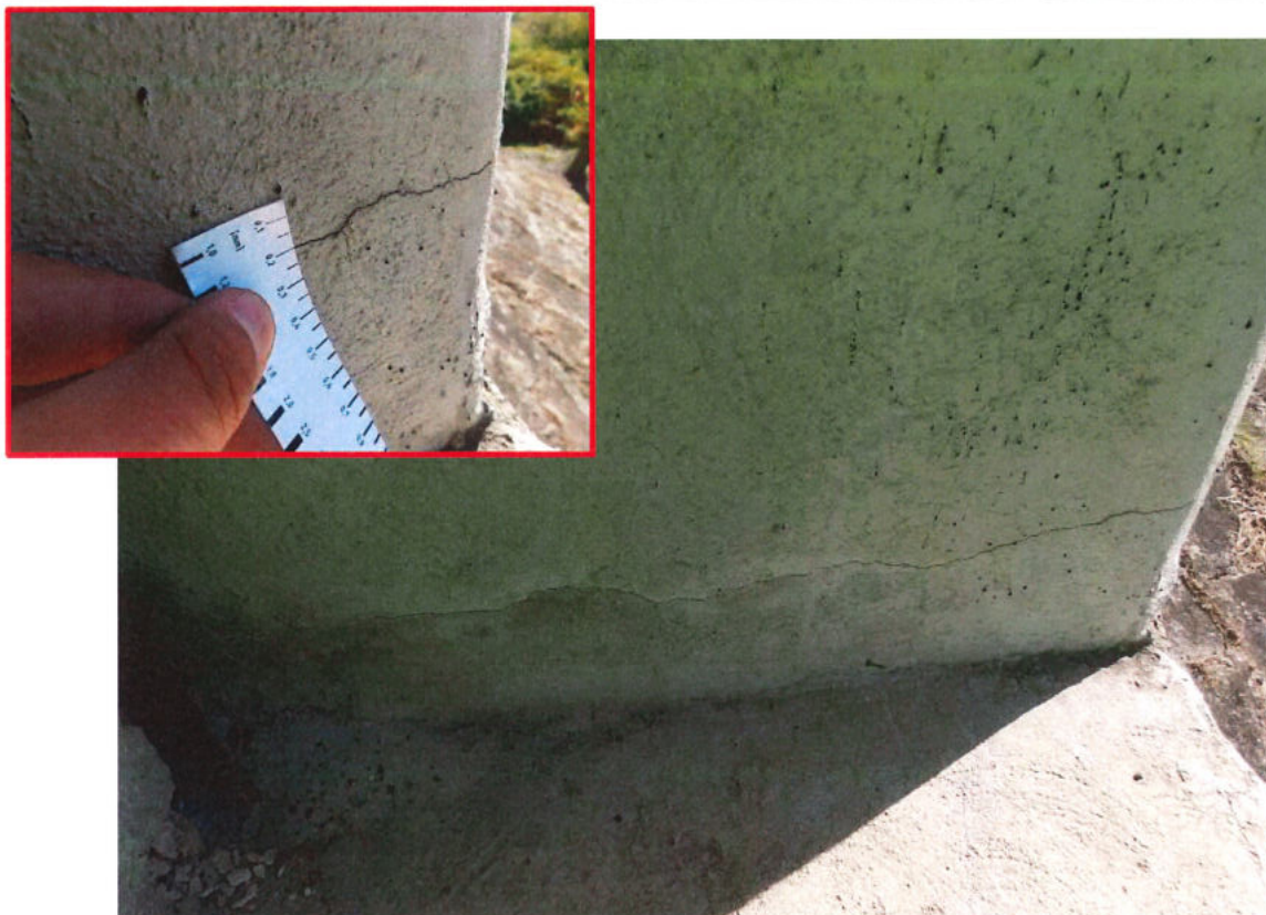
Fot. 55. Przyczółek od strony m. Szczucin – poziome zarysowanie ścianki zapleczonej przyczółka, rozwartość rysy wynosi 0,2 mm.
