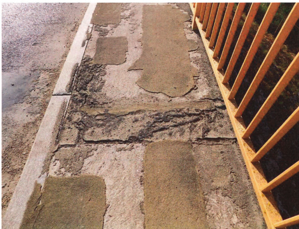
Fot. 24. Chodnik na obiekcie po stronie DW – liczne ubytki i wykruszenia żywicznej nawierzchni chodnika na obiekcie, widoczne ślady po naprawach nawierzchni.
