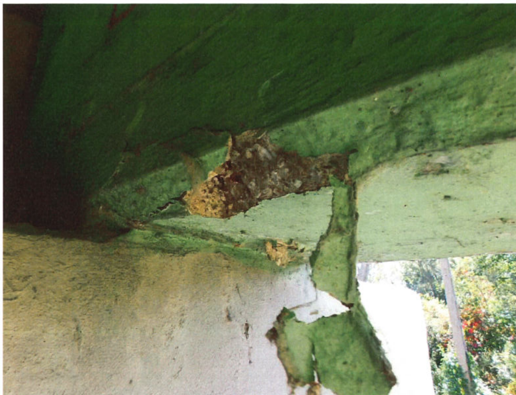
Fot. 43. Konstrukcja dźwigarów głównych – ubytek betonu skrajnego dźwigara po stronie GW nad przyczółkiem od strony m. Jaślany, widoczne odsłonięte korodujące zbrojenie.
