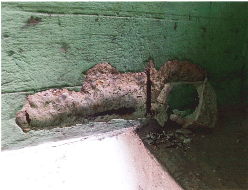
Fot. 41. Konstrukcja dźwigarów głównych – ubytek betonu skrajnego dźwigara po stronie GW nad przyczółkiem od strony m. Szczucin, widoczne odsłonięte korodującego zbrojenia.
