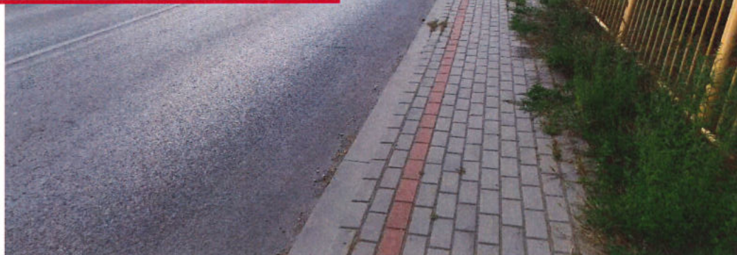
Fot. 26. Dojazd do obiektu od strony m. Jaśłany, dojście do obiektu / chodnik od strony DW – deformacje nawierzchni chodnika wraz z przemieszczeniem balustrady poza obszarem oddziaływania obiektu.
