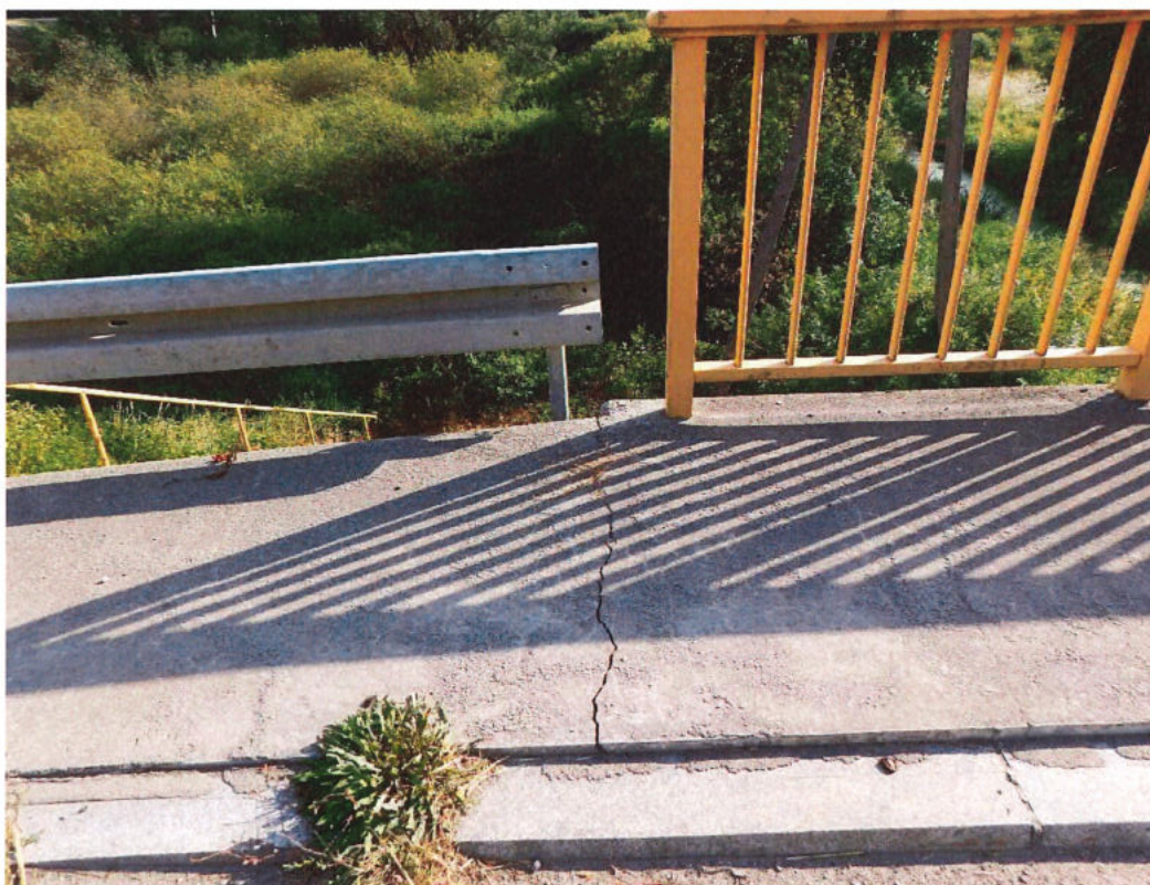
Fot. 22. Dojazd do obiektu od strony m. Jaślany, rampa od GW – poprzeczne pęknięcie nawierzchni chodnika na krawędzi skrzydła, widoczna wegetacja roślinności na styku z krawężnikiem.
