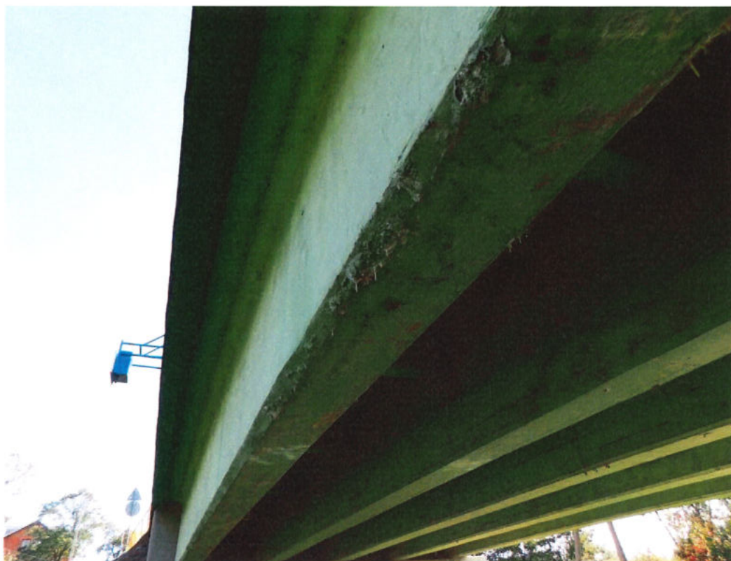
Fot. 39. Konstrukcja dźwigarów głównych – wapienne osady i zacieki na powierzchni skrajnego dźwigara głównego po stronie DW spowodowane przeciekami wody.
