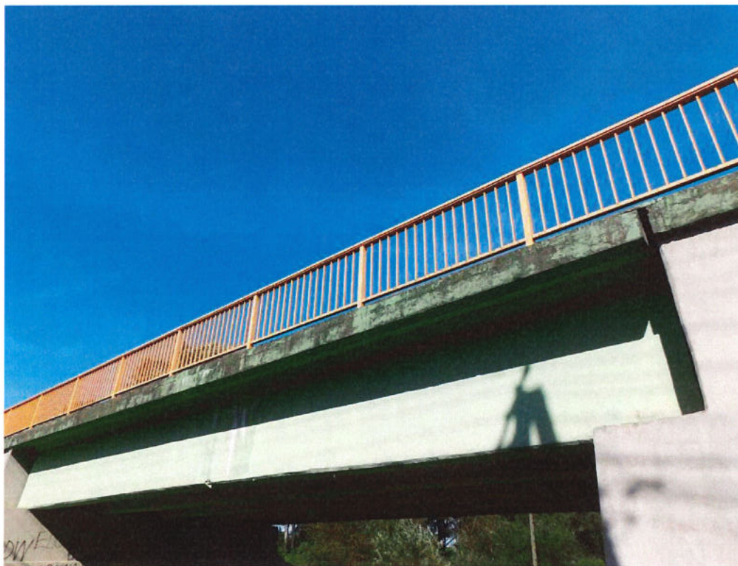
Fot. 34. Gzyms po stronie GW – zanieczyszczenia i osady na całej powierzchni gzymsu.
