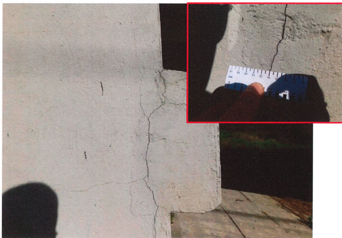
Fot. 48. Przyczółek od strony m. Szczucin – zarysowanie betonu w obrębie belki zakotwienia kotew gruntowych przyczółka od strony m. Szczucin, charakter rys ocenia się jako technologiczny.
