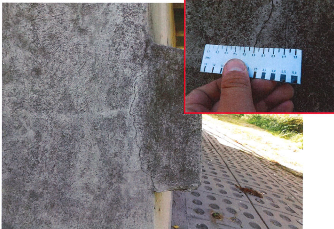
Fot. 54. Przyczółek od strony m. Jaślany – zarysowanie betonu w obrębie belki zakotwienia kotew gruntowych na przyczółku, charakter rys ocenia się jako technologiczny.
