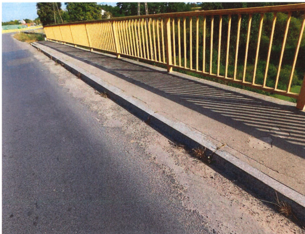
Fot. 15. Nawierzchnia jezdni na obiekcie – wykruszenia bitumicznej nawierzchni na krawędzi jezdni po stronie GW, widoczne zanieczyszczenia oraz miejscowa wegetacja roślinności na styku nawierzchnia - krawężniki kamienny.
