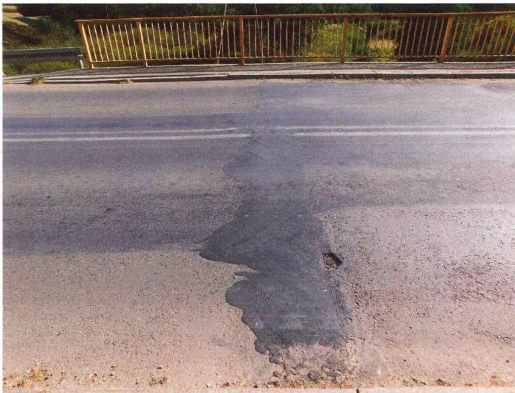
Fot. 37. Bitumiczne przykrycie dylatacyjne od strony m. Jaślany – deformacje i rozwalcowanie zalewki, widoczny lokalny ubytek nawierzchni jezdni na styku z urządzeniem dylatacyjnym.
