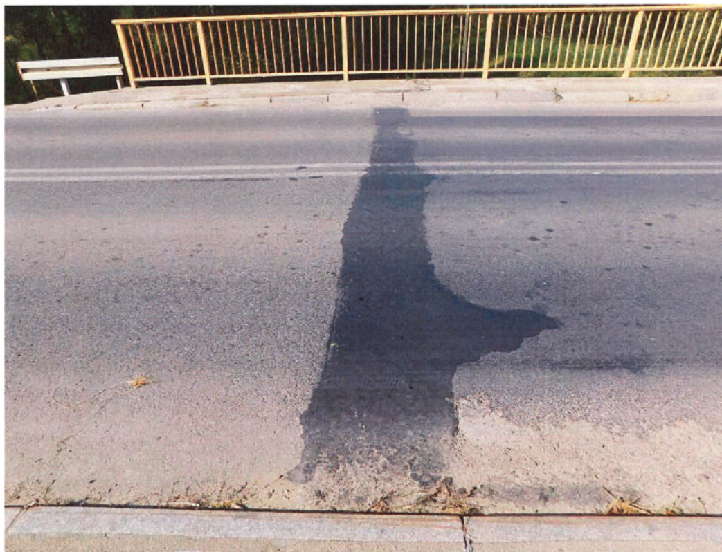
Fot. 8. Widok ogólny na bitumiczne przykrycie dylatacyjne od strony m. Szczucin.
