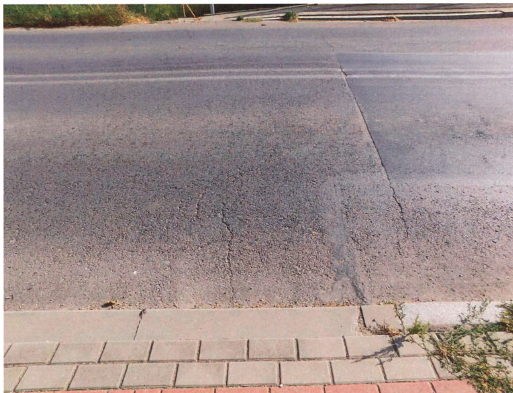
Fot. 18. Dojazd do obiektu od strony m. Szczucin – spękania i lokalne deformacje bitumicznej nawierzchni jezdni (brak płyt przejściowych).
