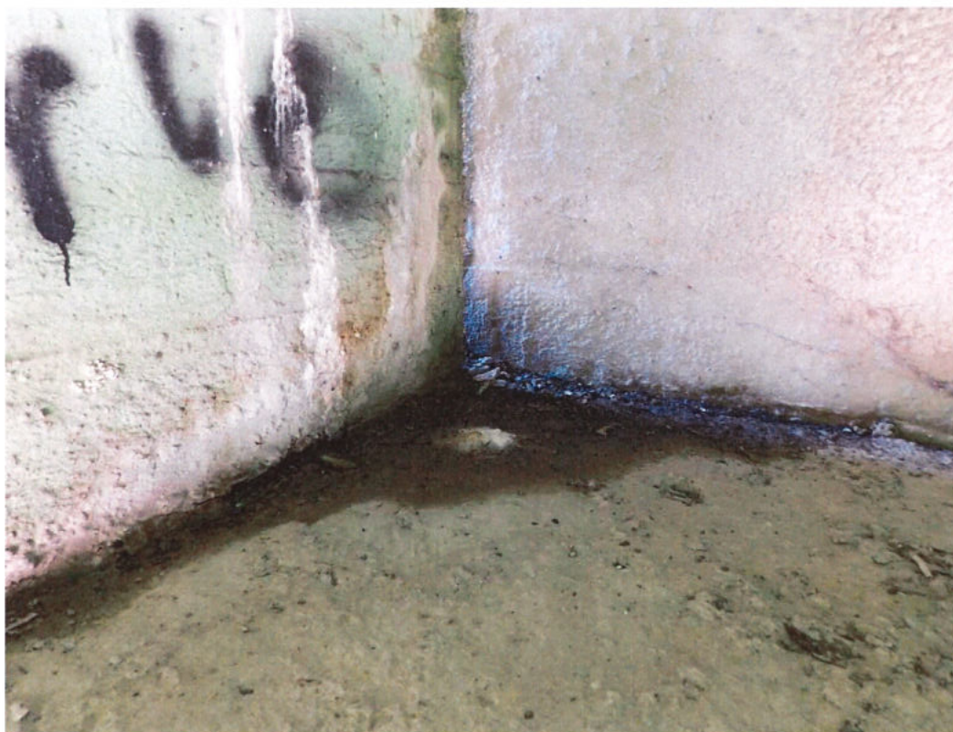
Fot. 56. Przyczółek od strony m. Jaślany – zanieczyszczenia i zawilgocenia na powierzchni ławy podłożiskowej spowodowane nieszczelnością w obrębie bitumicznego urządzenia dylatacyjnego.
