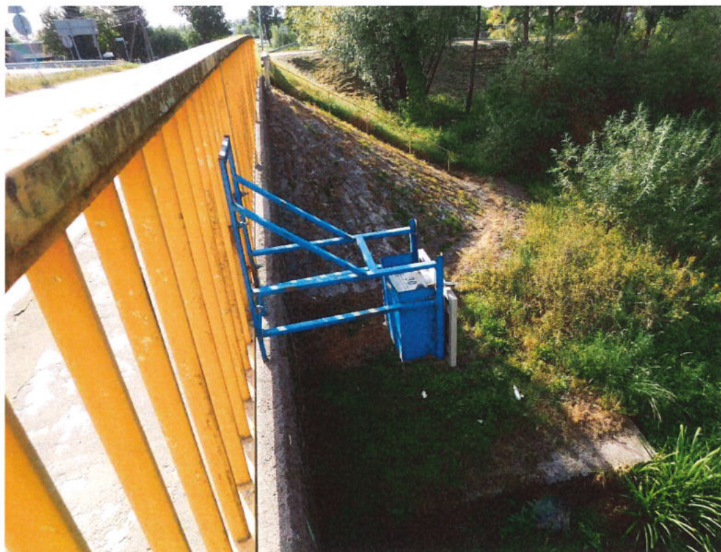
Fot. 62. Lokalne uszkodzenie zabezpieczenia antykorozyjnego wraz z powierzchnią korozją stalowego urządzenia obcego zamontowanego do balustrady na obiekcie.
