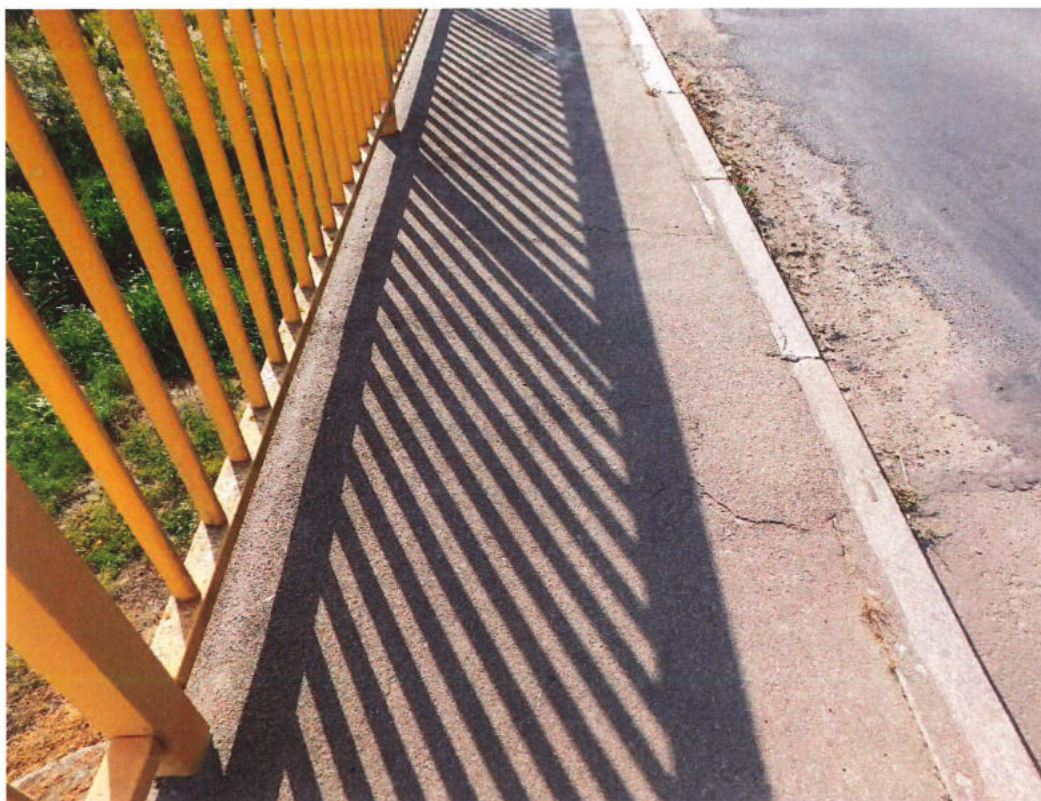
Fot. 25. Chodnik na obiekcie po stronie GW – lokalne spękania i deformacje żywicznej nawierzchni chodnika.
