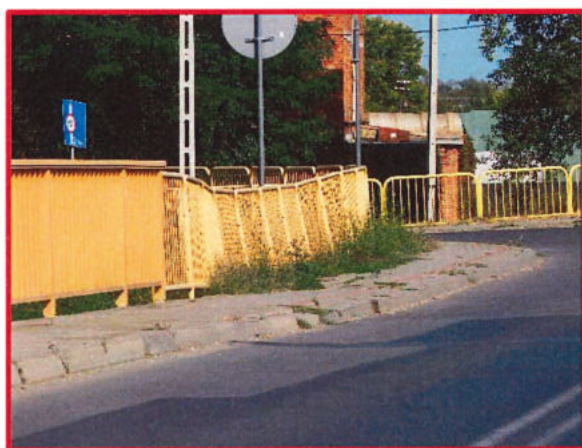
Fot. 25. Chodnik na obiekcie po stronie GW – lokalne spękania i deformacje żywicznej nawierzchni chodnika.
