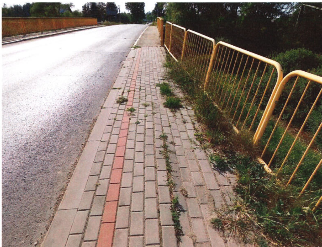
Fot. 21. Dojazd do obiektu od strony m. Jaślany, dojście do obiektu / chodnik od strony DW – deformacje nawierzchni chodnika wraz z przemieszczeniem balustrady poza obszarem oddziaływania obiektu, zanieczyszczenia oraz nadmiarowa wegetacja roślinności trawiastej.
